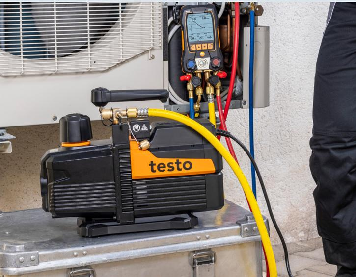
Rückschlagventil zur Vermeidung von Vakuumverlust bei Stromunterbrechung.
